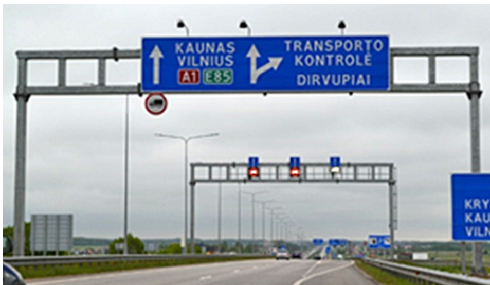
2 pav. Pirminė kelio ženklų atramos konstrukcija
